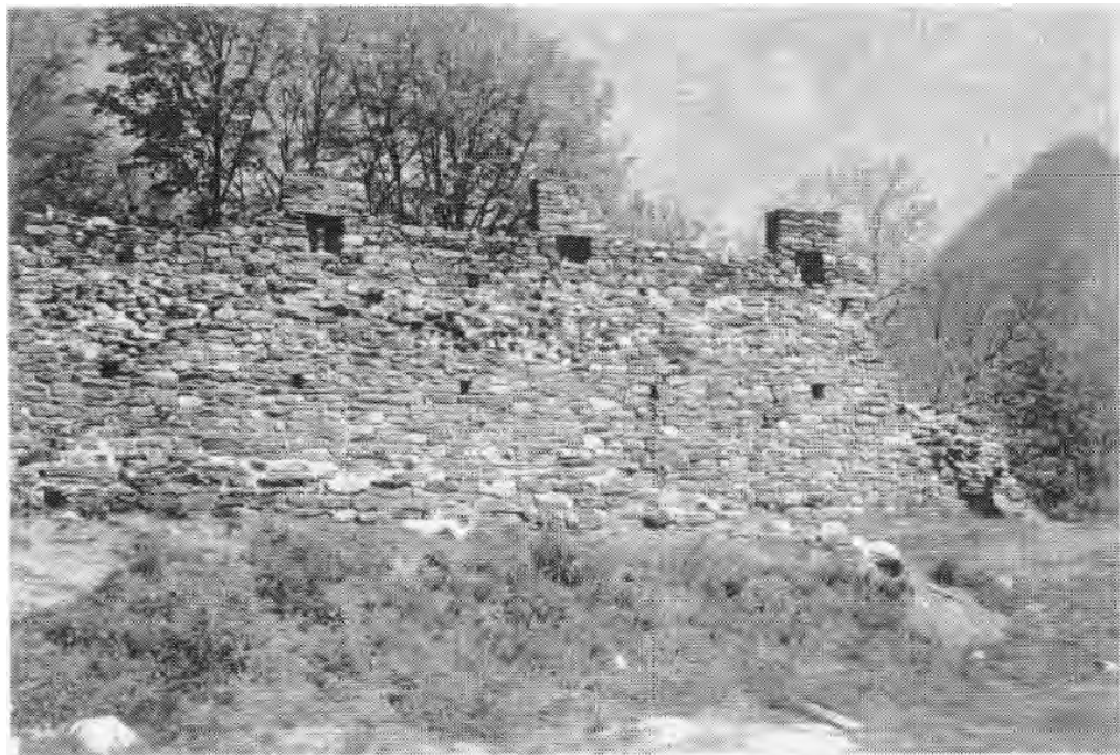
Die nördliche Ringmauer von Norantola, von S, wurde in zwei Bauphasen erstellt; deutlich erkennbar sind die Reste der Schwalbenschwanzzinnen samt den Schiesscharten. (Foto BVG)
